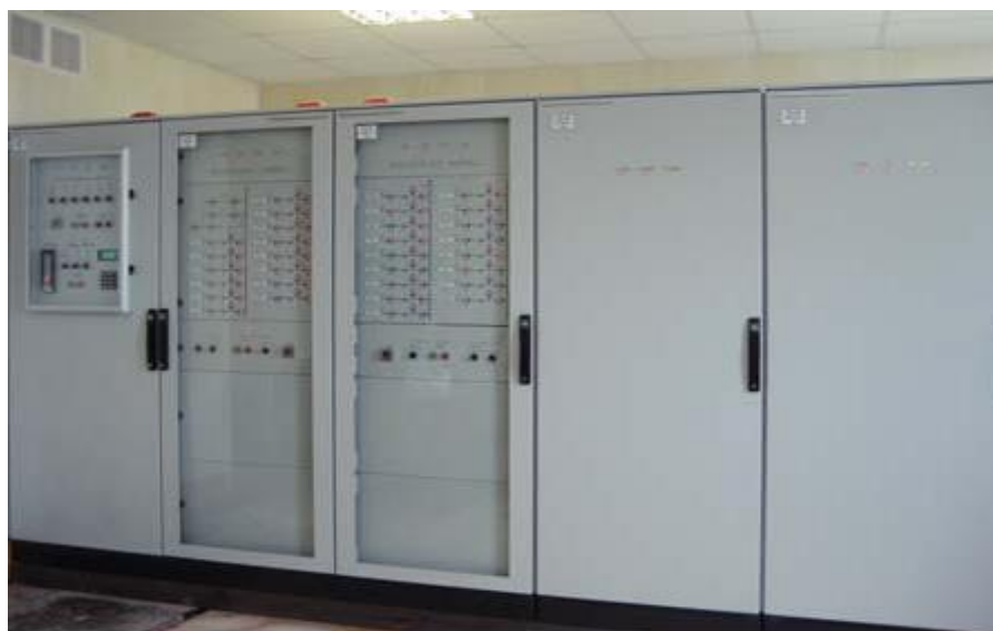
Рисунок 1.5 – Шкафы с аппаратурой САУ ГСП
